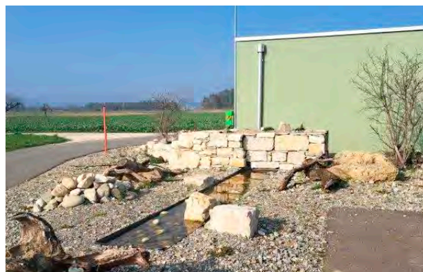
Neubau Pumpwerk Randweg
