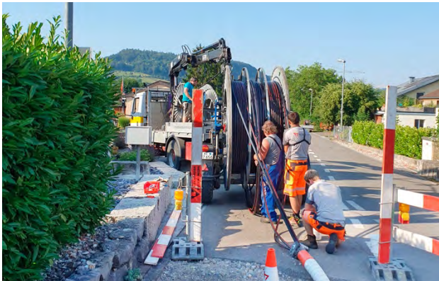
Kabeleinzug zur neuen Trafostation
