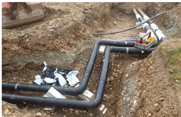
Umlegung der Fernwärme-Leitung an der Wiesenstrasse
