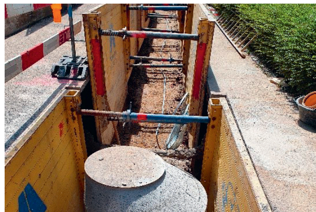
Erneuerung Kanalisations- und Wasserleitung Irisweg
