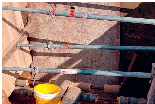
Rückbau eines Hausanschlusses der Fernwärmeleitungen und des Leckortungssystems bei Neuanschlüssen
