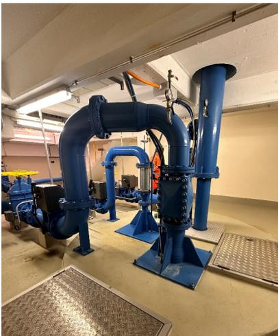
Abbildung 1: aktuell, bestehende Verrohrung der Pumpendruckleitungen
