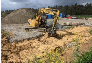
Gewässer erstellen mit Bagger
