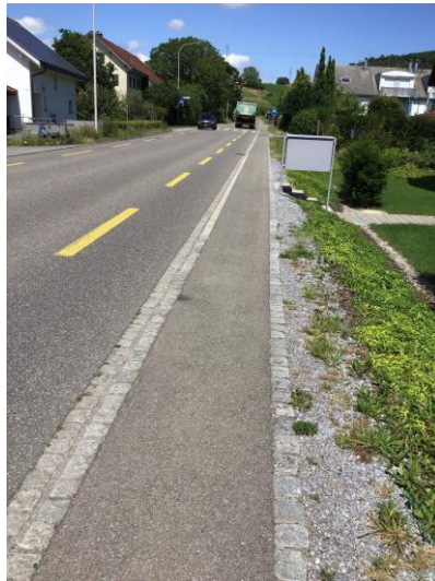
Abbildung 22: schmales Trottoir Tegerfelderstrasse
