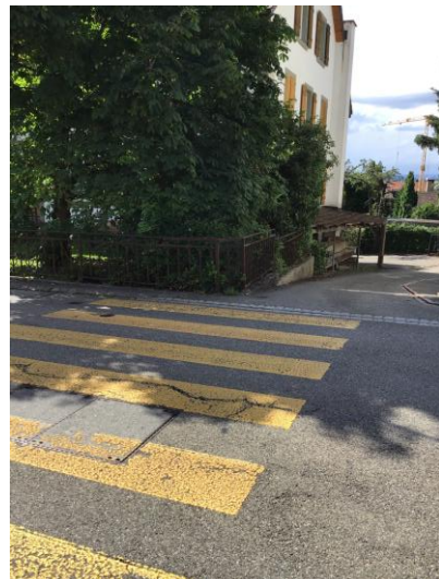
Abbildung 21: Hindernis im Warteraum und fehlende Schutzinsel
