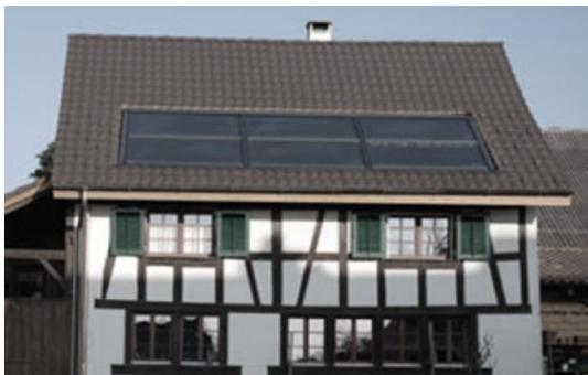
Abb.3 Anordnung unterer Dachbereich, Integration in Dachhaut, farblich einpassen (Foto: D. Zehnder)
