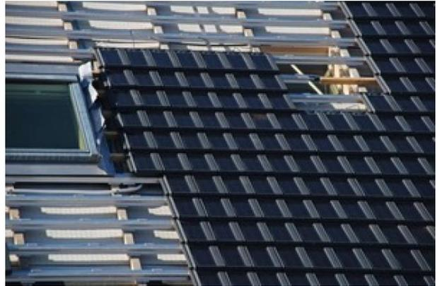
Dachziegel mit Solarmodul
